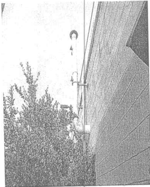
Foto 7. Chimenea proveniente del proceso de cementado.
